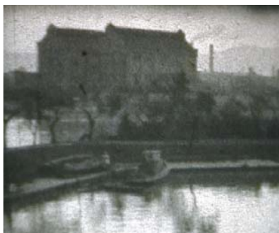
■ [ 図① ] 京阪電車の発電所跡 毛馬にあり、この発電により近郊の民家にも電気の供給が可能になった。 (写真: 中村英祐)
