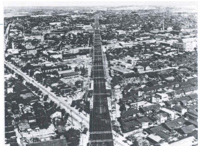
■ [図⑥] 昭和8年頃の完成した高架複々線路(関目駅より森小路駅方面の景観)
