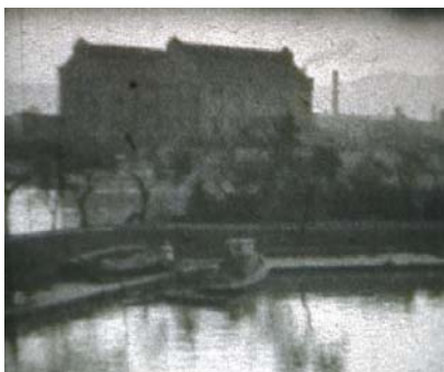
■ [ 図① ] 京阪電車の発電所跡 毛馬にあり、この発電により近郊の民家にも電気の供給が可能になった。 (写真: 中村英祐)
