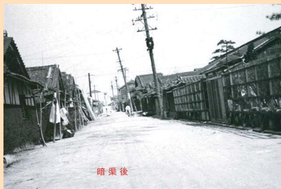
■井路川暗渠後の様子 <現在の森小路2丁目付近/昭和30年頃> (写真:中村英祐)
