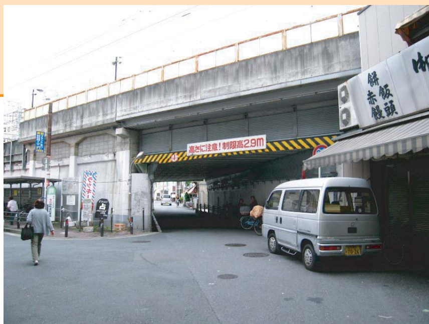
■現在の野崎ガードと推測される場所 (平成20年10月撮影)
