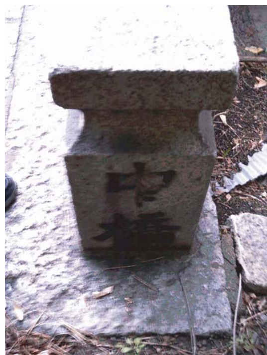
■現存する橋の親柱
