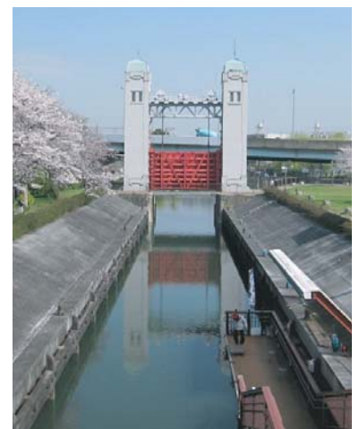
■三栖閘門前扉室 (写真:淀川河川事務所)
