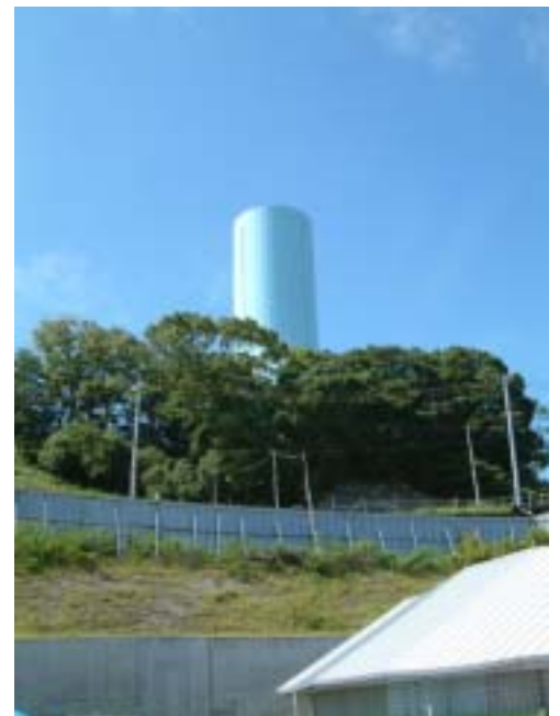
写真上) 神戸長田出入路付近の蓮宮換気所
