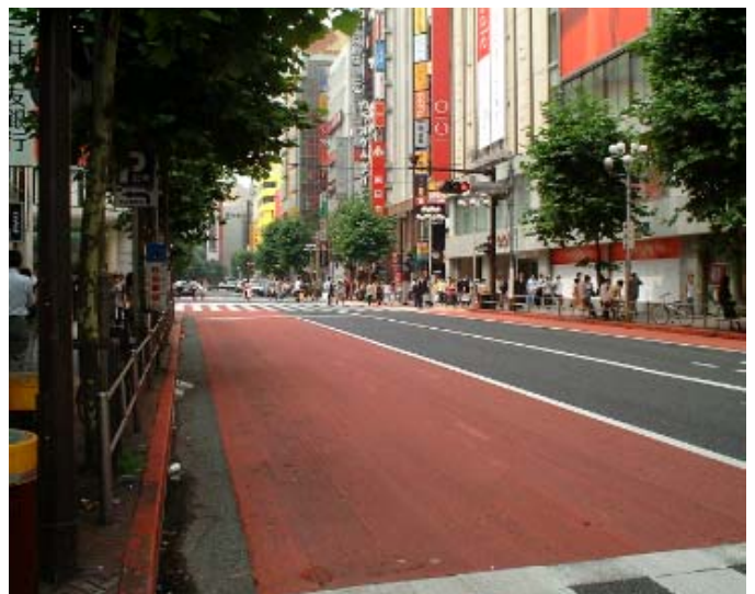
写真5 ガラガラ舗装
