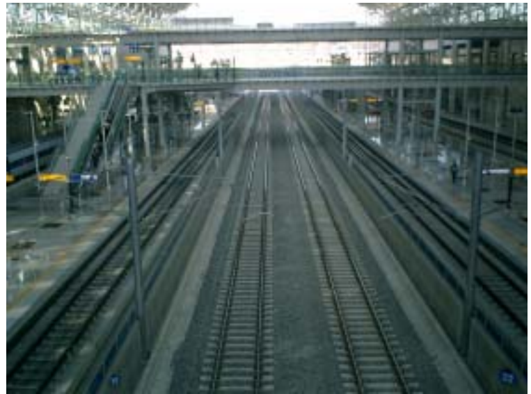
光明駅構内（線路が 6 本）
