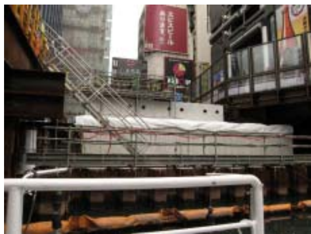
建設中の戎橋橋台（右岸側）
