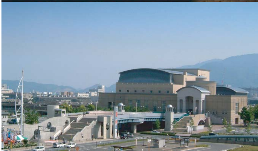
人工地盤全景
